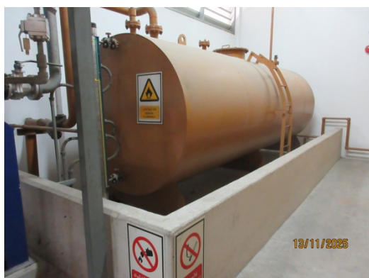
รูปที่ 55 กังพองคอนกรีตล้อมรอบถังน้ำมันและสารเคมี
